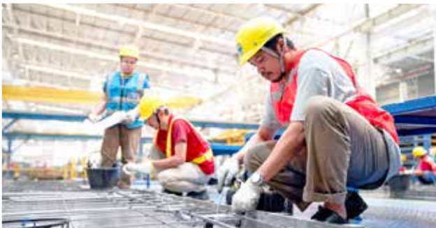
Embedded Installation : การติดตั้งวัสดุผัง เช่น งานระบบประปา งานระบบไฟฟ้า ตามที่ ระบบ Robot อัตโนมัติได้ทำการ Plot ไว้
