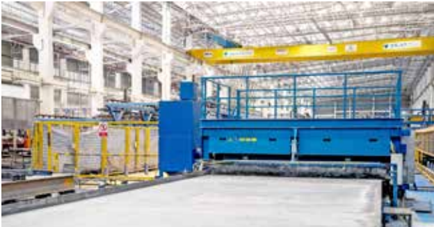
Cleaning & Oiling Station : การทำความสะอาดผิวโต๊ะหล่อและสเปรย์น้ำมันยาทาแบบ ด้วยระบบเครื่องจักรอัตโนมัติ
