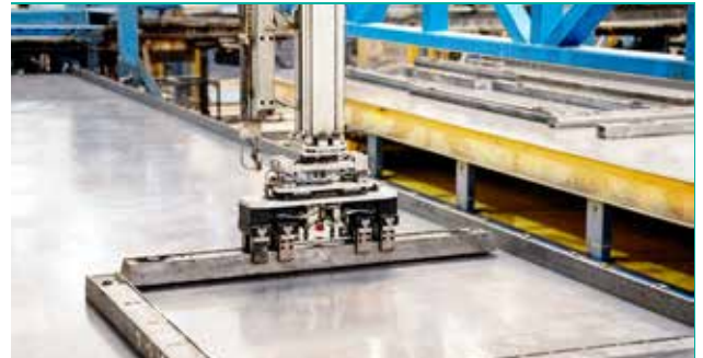
Plotting & Shuttering Robot : การ Plot ตำแหน่งวัสดุผังและการวางแบบข้าง Shuttering แบบข้าง ด้วยระบบ Robot อัตโนมัติ
