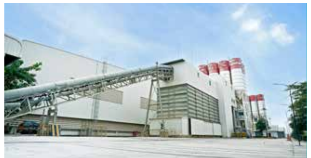
Batching Plant : โรงงานผสมคอนกรีตที่เป็นระบบปิดจึงทำให้ไม่มีฝุ่น ถือเป็น Green Factory แห่งแรกของไทย
