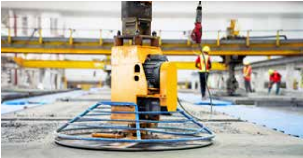
Smoothing : การขัดแต่งผิวหน้าคอนกรีตให้เรียบ โดยใช้เครื่องขัด Helicopter ด้วยระบบอัตโนมัติ
